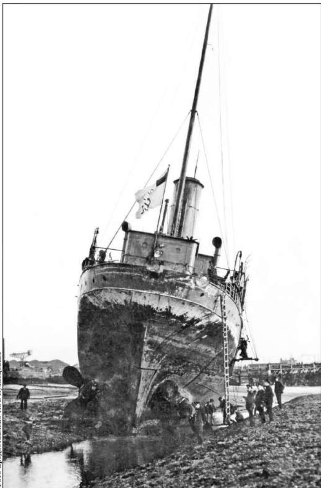
«Канада» на осушке вблизи Архангельска во время осмотра поврежденных гребных винтов. 1916 год
